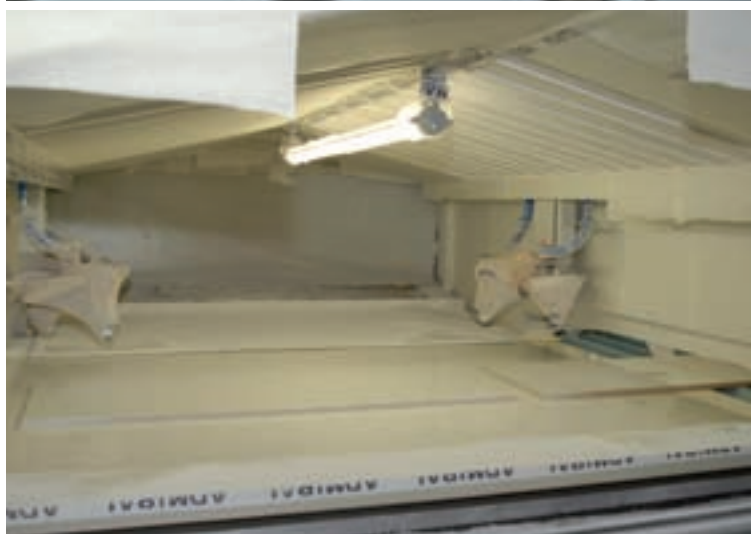
La moderna línea de pintado rociado, totalmente automatizada.
