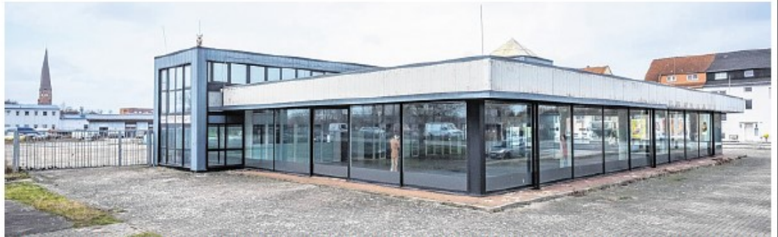
Die neue Rostocker Spielbank soll in das alte Autohaus Niemann am Petridamm einziehen. Anfang 2023 ist der Umzug vom Kabutzenhof an den neuen Standort geplant.
