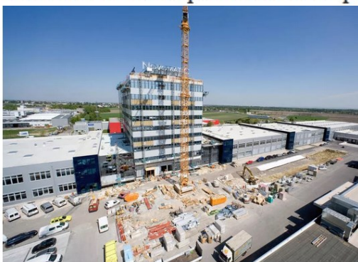
Bau des Novomatic-Headquarters im Jahr 2009 © Novomatic
