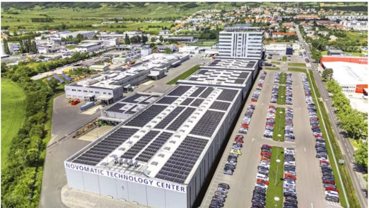
Die riesige Dach-Photovoltaik-Anlage
