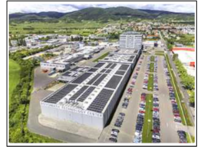
© Novomatic / Die neue PV-Anlage am Dach
