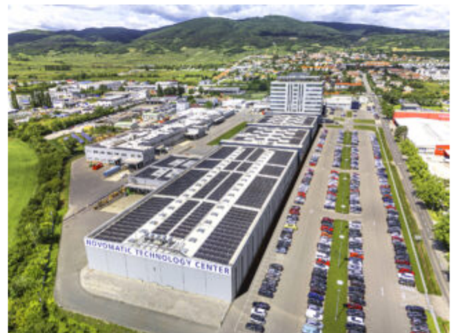
Die konzernweit größte Photovoltaik-Anlage auf den Dächern der Unternehmenszentrale in Gumpoldskirchen. (Foto: NLK Burchhart)
