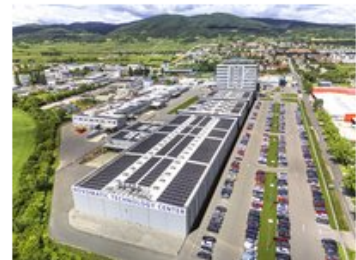
4 600 Solarpaneele wurden auf den Novomatic-Dächern in Gumpoldskirchen installiert. Foto: NLK Burchhart
