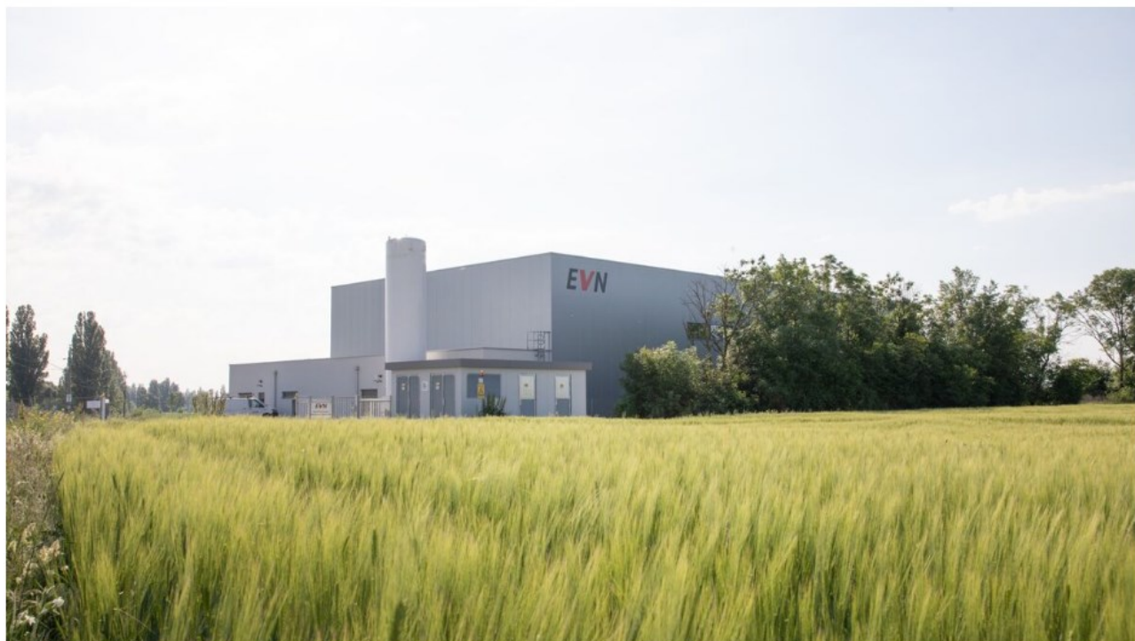
Naturfilteranlage Petronell-Carnuntum der EVN NÖ
