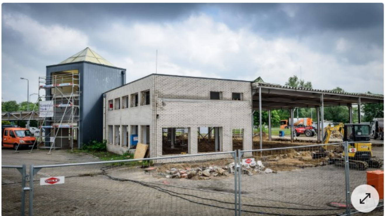
Beginn der Bauarbeiten Mitte 2024: Das ehemalige Autohaus am Petridamm in Rostock wurde komplett entkernt. (Foto: Georg Scharnweber)
